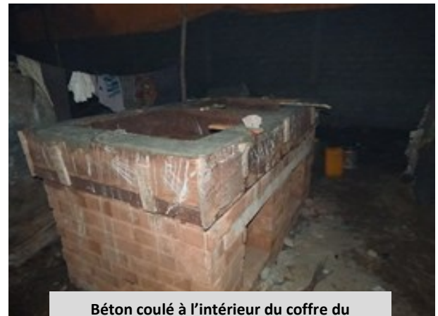
Béton coulé à l'intérieur du coffre du chaînage
