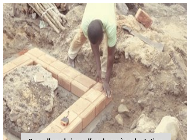
Pose d'une brique d'angle après adaptation de la dimension de la brique
