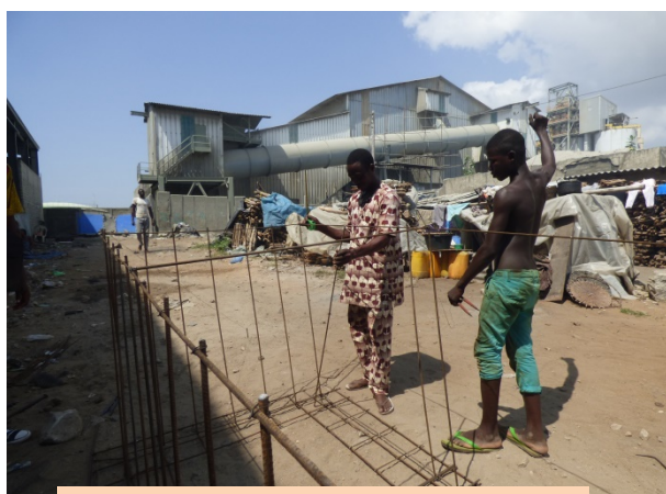
Réalisation du ferrailage de l'ouvrage
