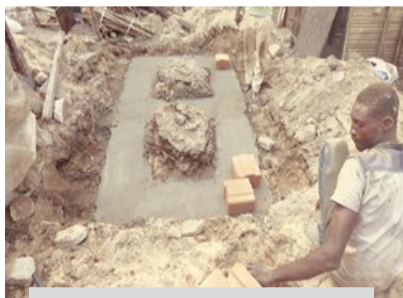
Fondation de l'ouvrage réalisée avec succès
