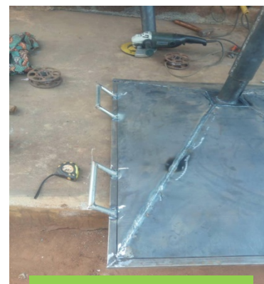
Vue partielle du couvercle en cours de fabrication
