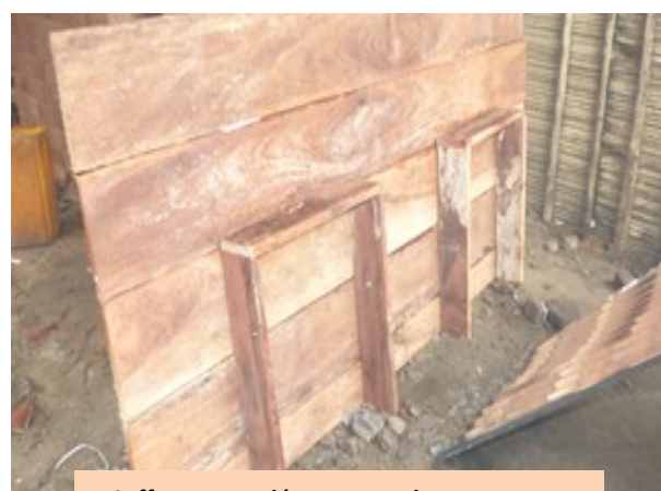
Coffrage avec dégagement des ouvertures des portillons
