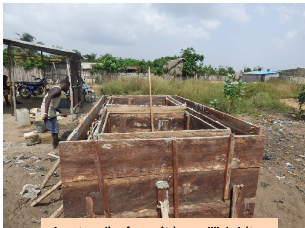
Armature d'un four prêt à recueillir le béton
