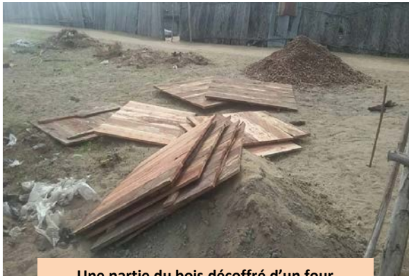
Une partie du bois décoffré d'un four
