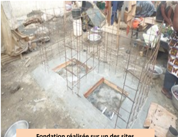
Fondation réalisée sur un des sites
