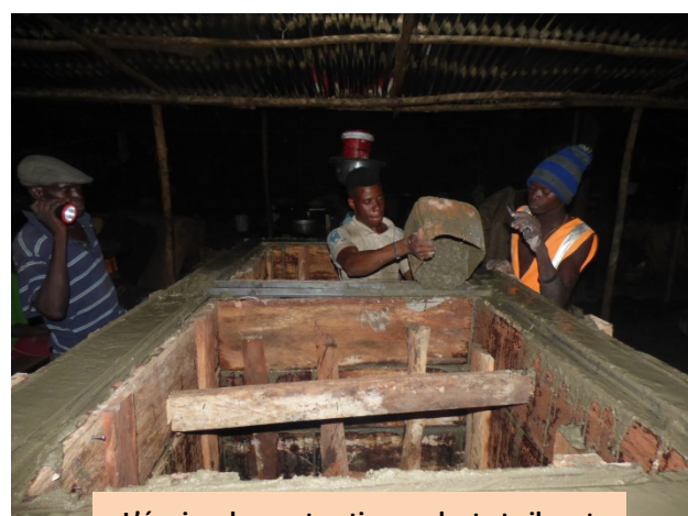
L'équipe de construction coulant et vibrant le béton d'un four
