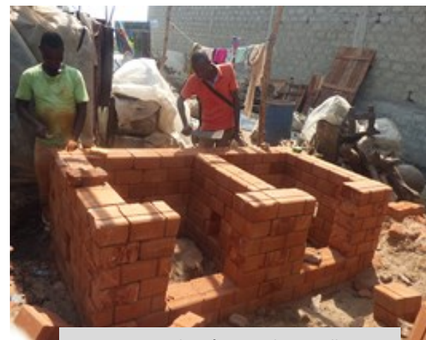
Ouvertures laissées pour les portillons
