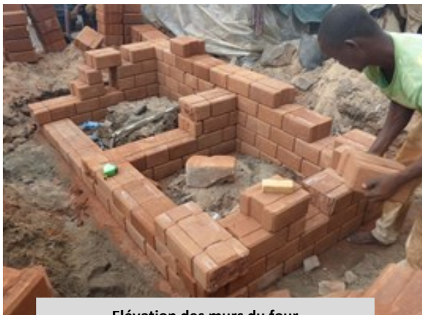
Elévation des murs du four
