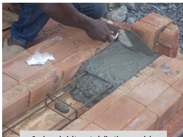
Coulage du béton et réalisation au sol du linteau
