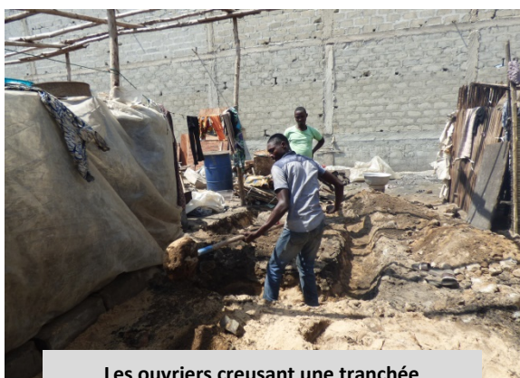
Les ouvriers creusant une tranchée
