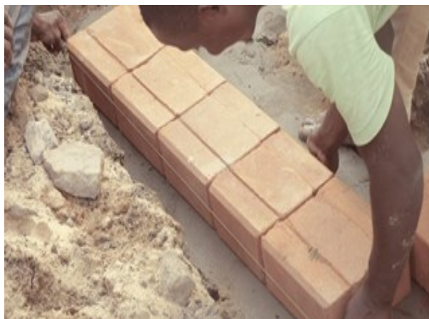
Contrôle de l'alignement des briques
