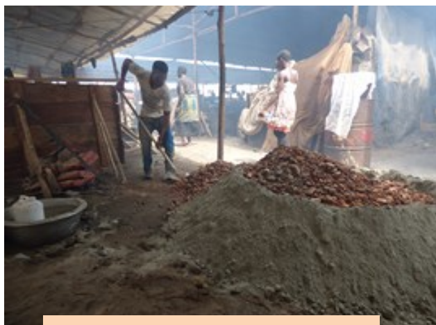
Réalisation et dosage du béton
