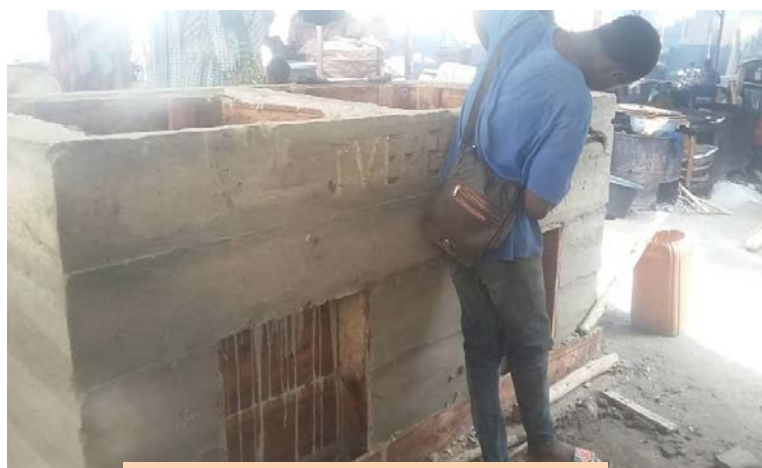
Un ouvrier entrain de décoffrer l'extérieur du four
