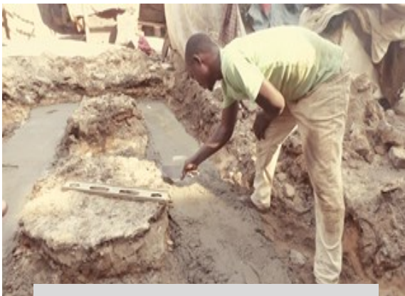
Coulage du béton de propriété
