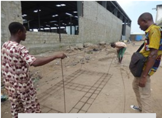
Les ouvriers réalisant un ferrailage
