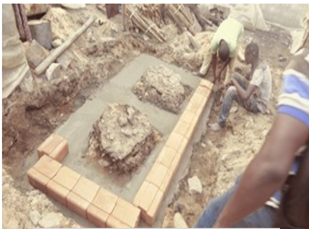
Pose et assemblage de la 1 ère couche de briques
