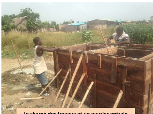
Le chargé des travaux et un ouvrier entrain de renforcer et corriger le coffre
