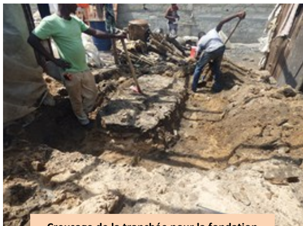
Creusage de la tranchée pour la fondation
