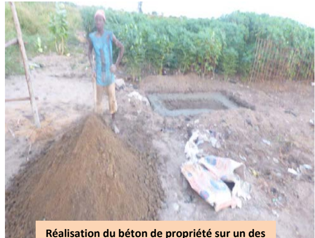
Réalisation du béton de propriété sur un des sites
