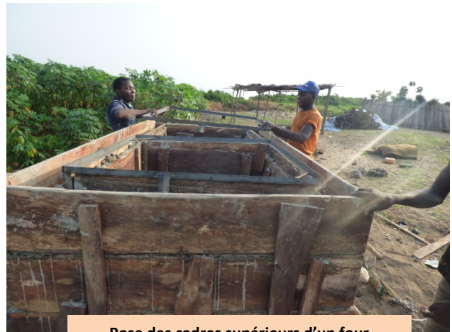
Pose des cadres supérieurs d'un four
