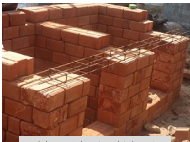
Vérification du ferrailage réalisé pour le linteau des portillons
