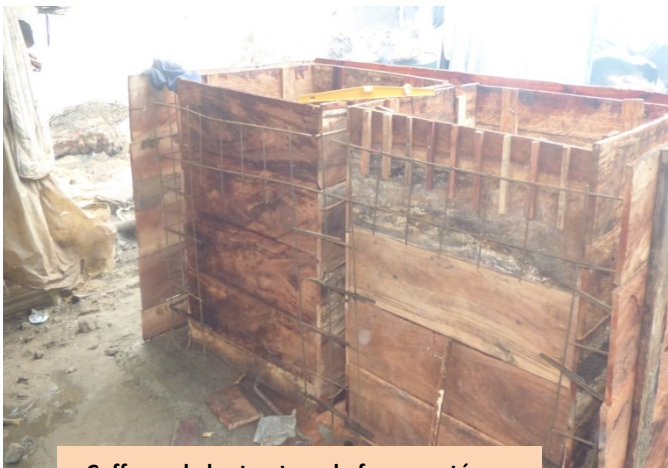
Coffrage de la structure du four monté aux 3/4
