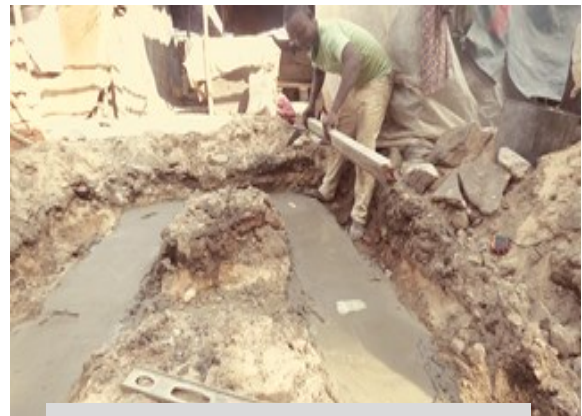
Nivellement du sol
