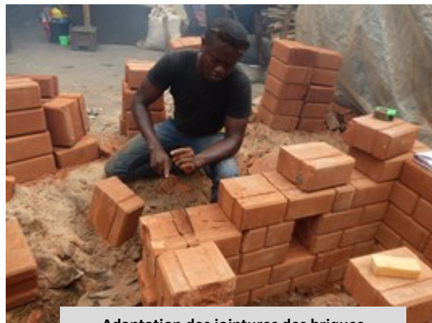
Adaptation des jointures des briques
