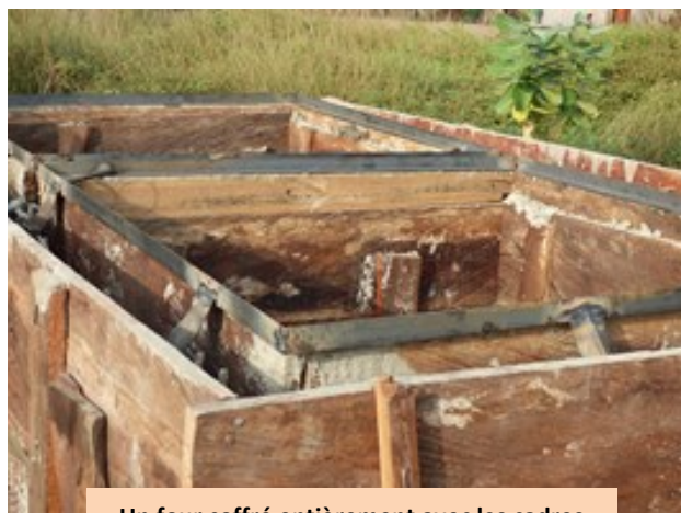
Un four coffré entièrement avec les cadres posés
