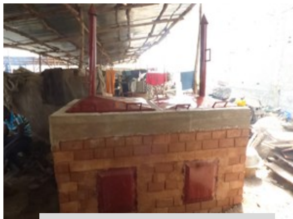
Four en briques autobloquantes finalisé avec ses accessoires
