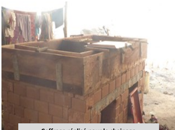
Coffrage réalisé pour le chaînage
